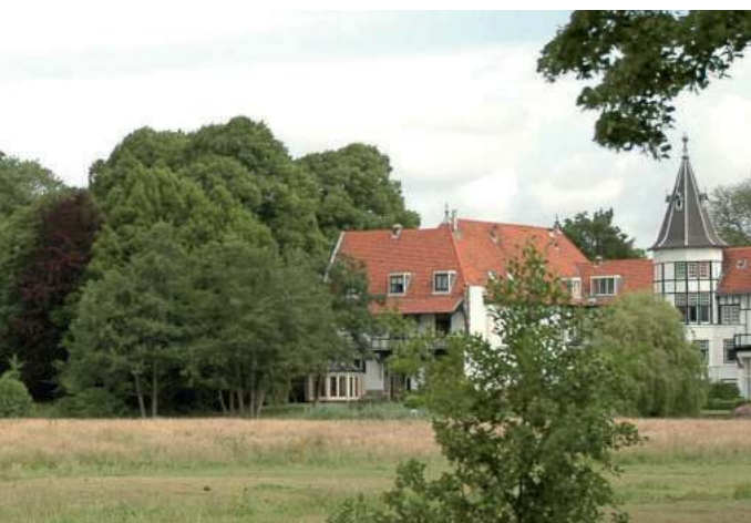
Duin en Daal te Bloemendaal. De grote dakvlakken kunnen een volwaardig appartement herbergen. Oppassen met het formaat van de dakkapellen
