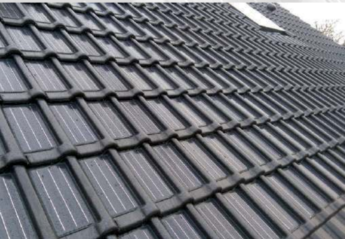
Dakpannen met klassieke uitstraling en geïntegreerde zonnepanelen.
