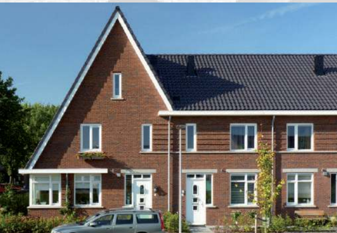
Een nieuw gebouwd rijtje, 's-Gravenmoer. Een verspringing in de gevel tussen de hoekwoning en de rest zou mooi zijn.
