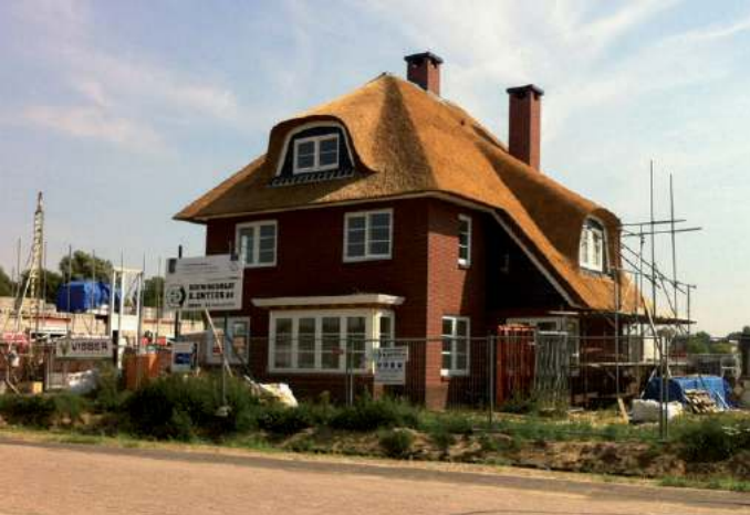
Woning in aanbouw langs de Bankenlaan
